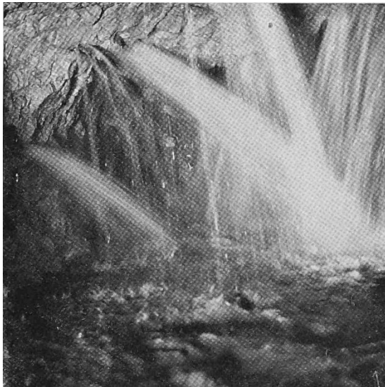
Abbildung 3: Wasserzutritte im Grenchenberg-Tunnel
